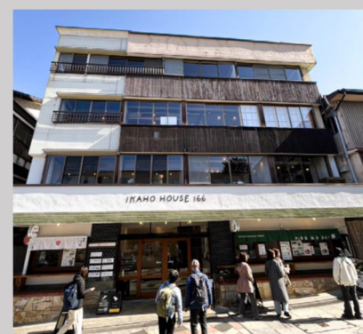
築 100 年超の旧旅館を 飲食・体験などの複合施設に改修
