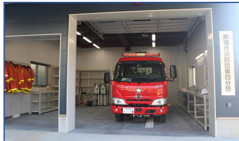
(消防ポンプ自動車車庫)
