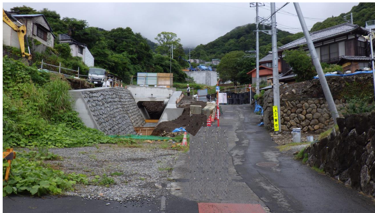
No.6 道路工事②付近 R8.6
