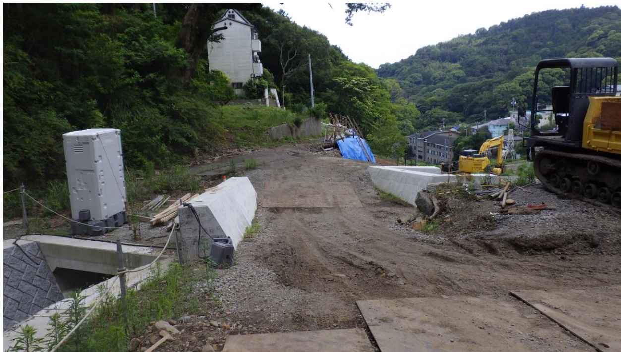
No.12 引地堀坂支線拡幅工事付近 R8.6
