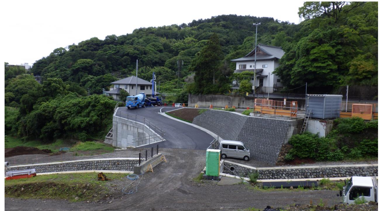
No.10 取付道路整備工事付近 R8.6
