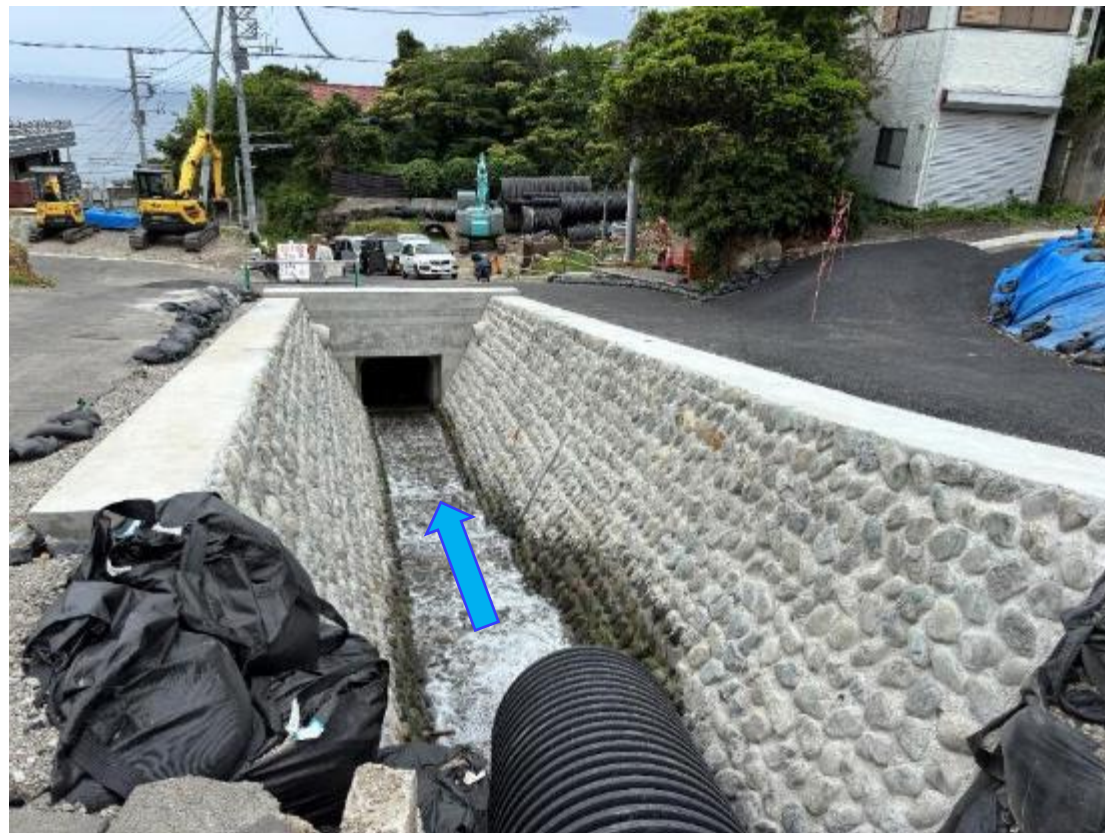
施工中 (R8. 6. 2 撮影)
