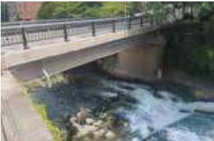
長寿命化工事完成後
