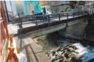
長寿命化工事着手前
