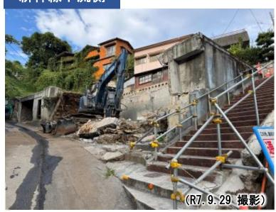
準備工事として家屋解体に着手 (函渠据付の際の施工ヤードとして使用予定)
