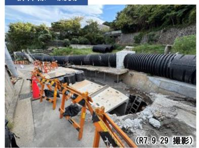
全体74mのうち、 約50mの函渠据付が完了(R7.9.30 現在)
