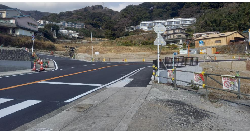
河川拡幅工事（完了） 市道伊豆山神社線 R7.1
