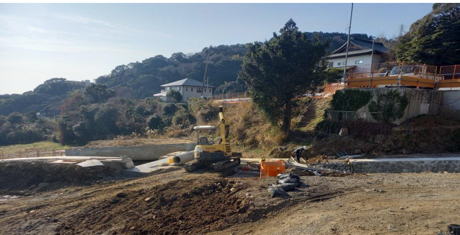
河川・道路工事 市道伊豆山神社線取付部 R7.1
