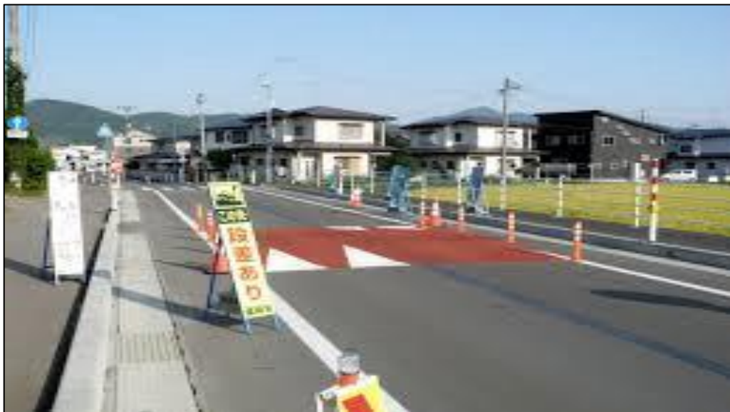
スピード抑制のための道路段差（イメージ）
