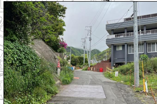
起点(下流側から撮影)
