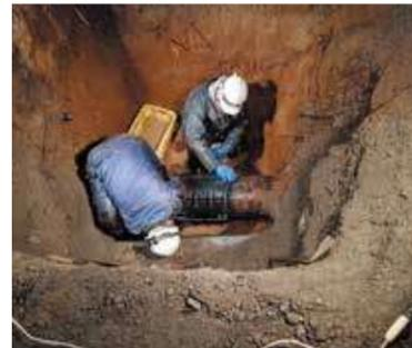
老朽化により漏水した水道管の修繕工事
