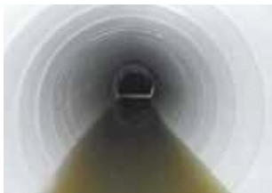
老朽化対策(更正工事)後の 下水道管▶
