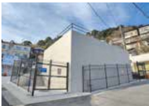
◀和田山第3配水池 (令和7年1月完成)
