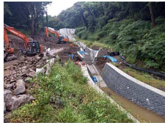
砂防工事实施中（流路工） R6.10
