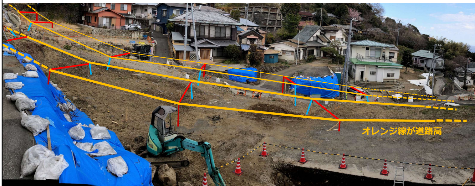
現場説明会 パノラマ写真（丁張りの様子） ※岸谷2号線から岸谷本線方面を撮影
