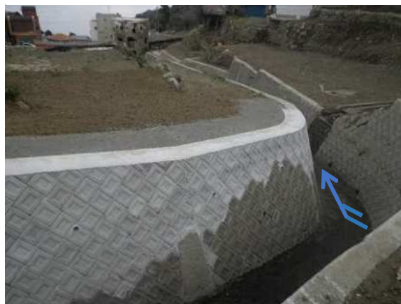
災害復旧工事施工済箇所 （コンクリートブロック積み工）
