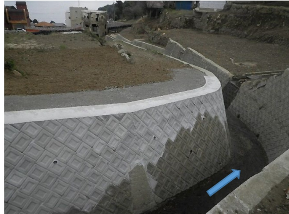
災害復旧工事施工済箇所 （コンクリートブロック積み工）
