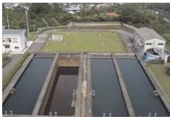
宮川浄水場 沈殿池
