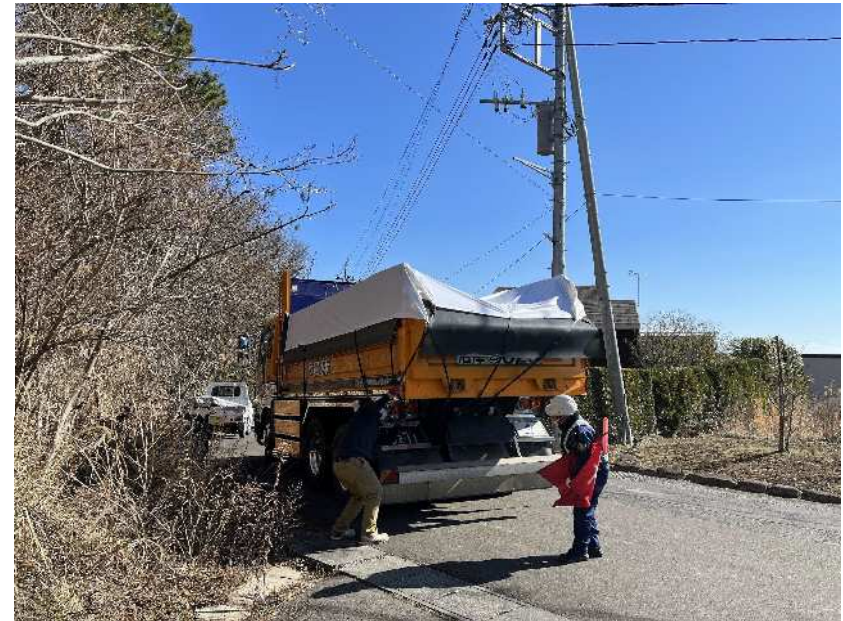
土砂運搬状況
