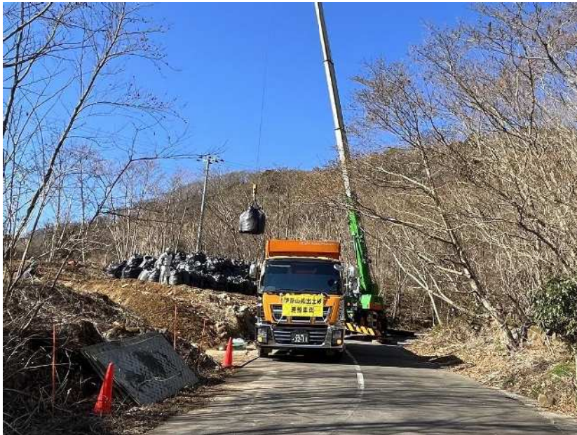
土砂搬出状況
