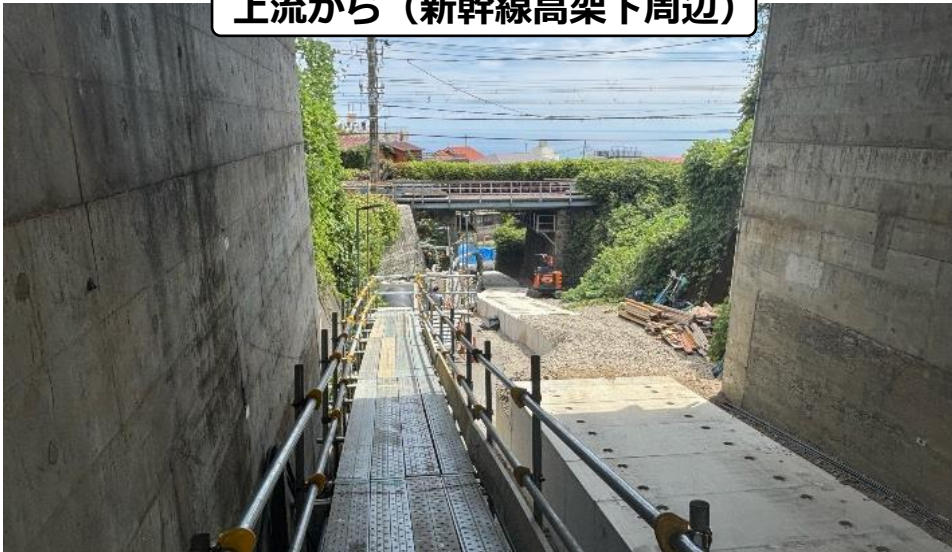
上流から（新幹線高架下周辺）
