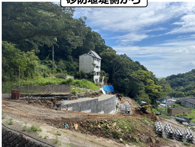
砂防堰堤側から
