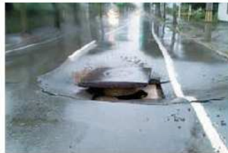
【マンホール周辺の道路状況】
