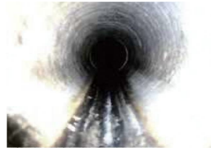
清掃後の管内
