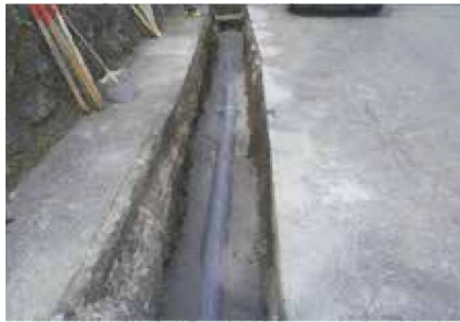
埋設された下水道管
