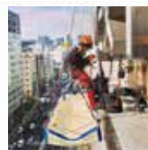
看板設置 点検
