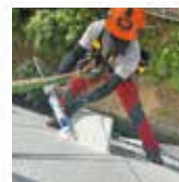
塗装・シーリング 付帯設置工事等
