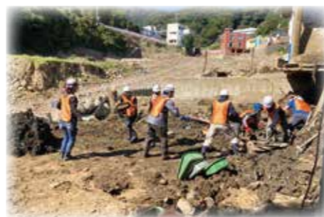
▲土砂撤去作業
