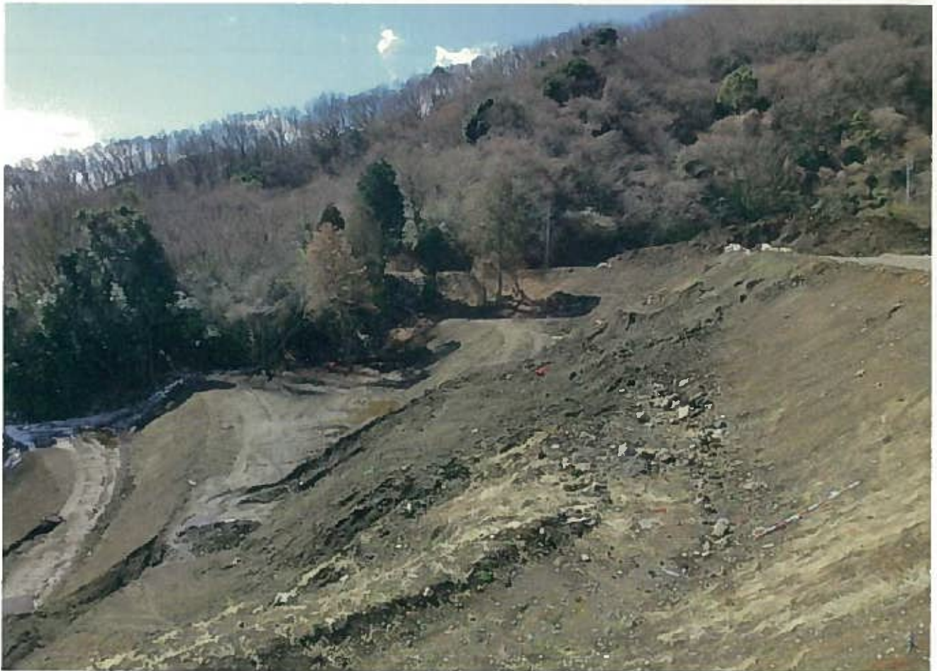
写真6 2011(平成23)年3月4日 県及び市で合同調査
