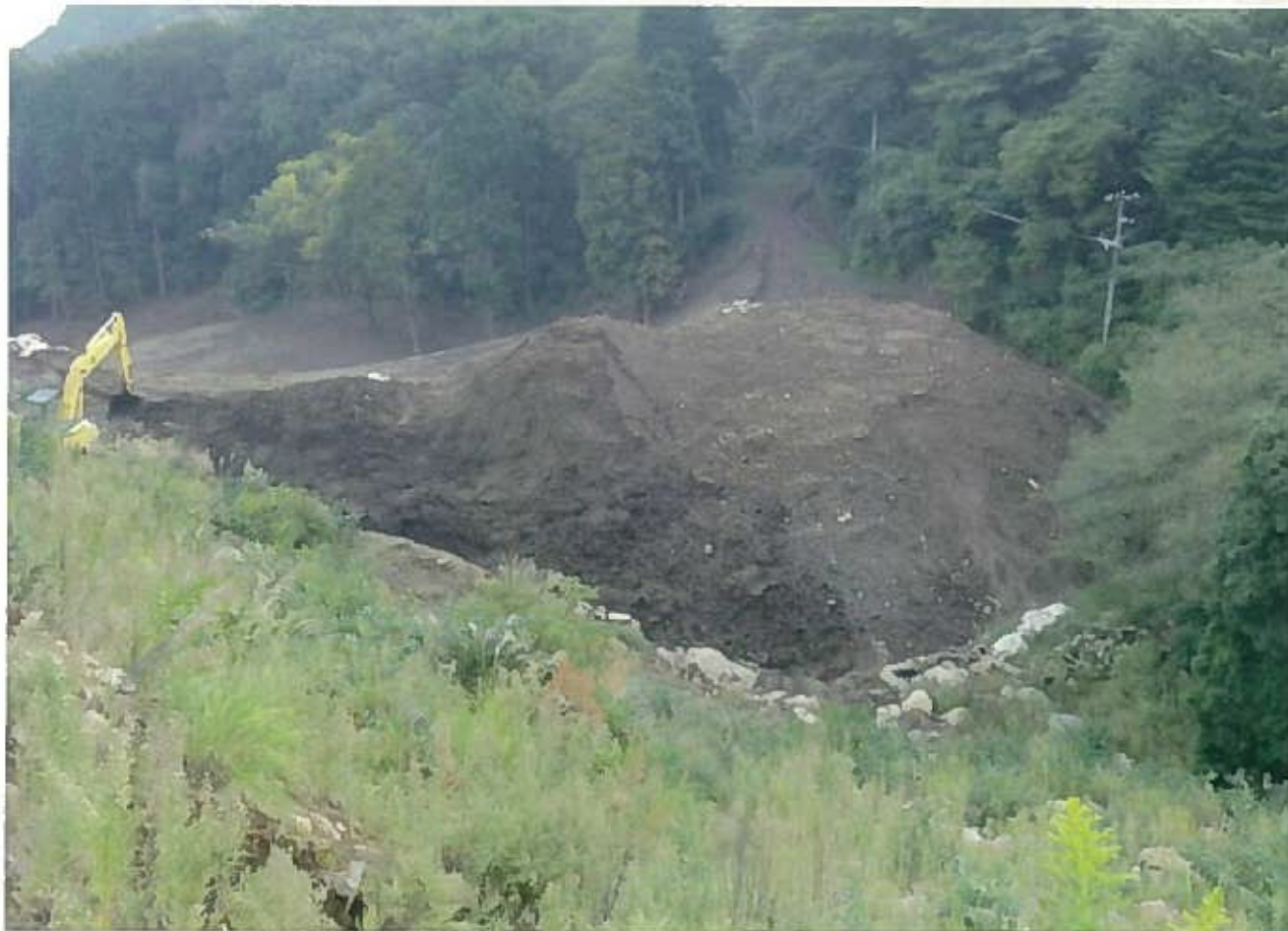
写真 4 2010(平成22)年10月13日 調圧槽手前に大量の土砂を確認
