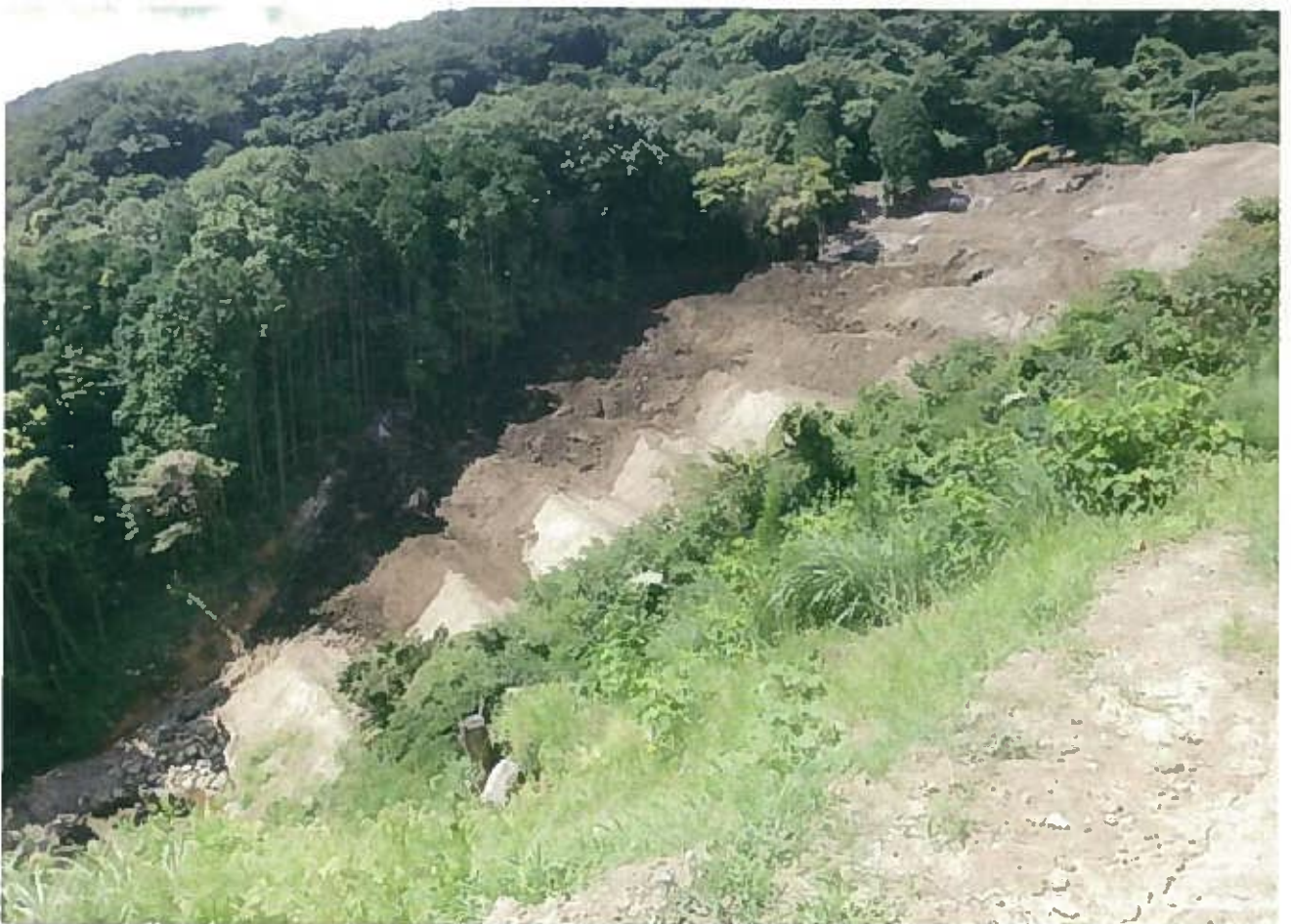
写真3 2010(平成22)年8月30日 崩落した土砂の成形作業を確認
