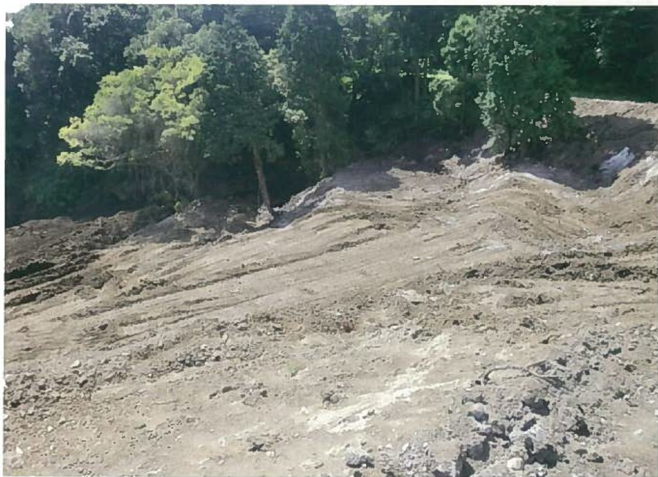
写真3 2010(平成22)年8月30日 崩落した土砂の成形作業を確認
