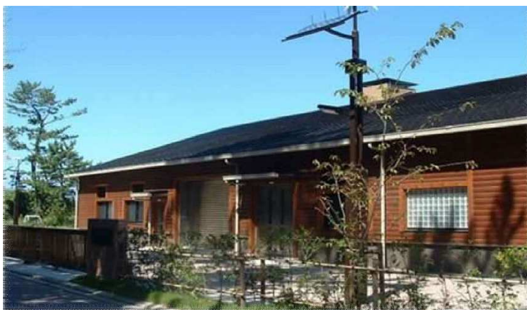
図 2.1 初島漁業集落排水施設（熱海市初島浄水管理センター）
