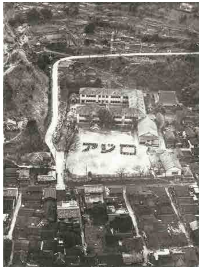
昭和8年8月 木造2階建18教室
