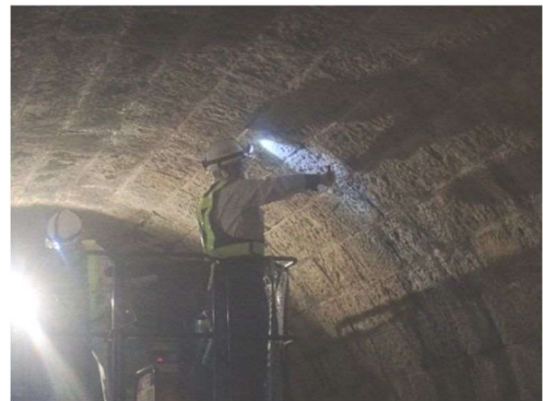
近接目視・打音検査状況
