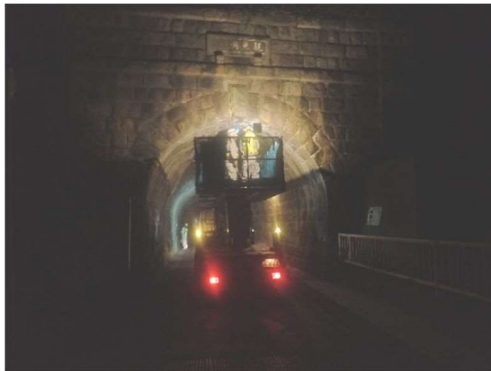
定期点検状況（観魚洞トンネル）
