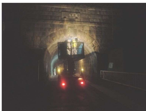
定期点検状況（観魚洞トンネル）
