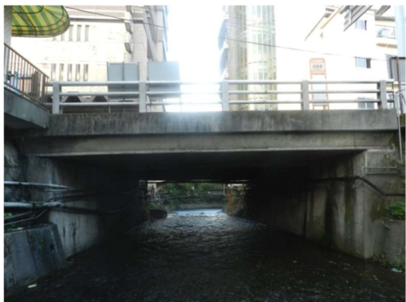
【RC 橋】 染殿橋（熱海駅和田浜線）
