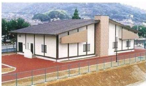
南熱海中継ポンプ場
