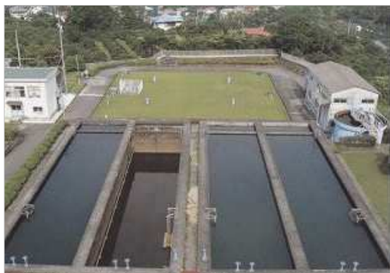
宮川浄水場 沈殿池
