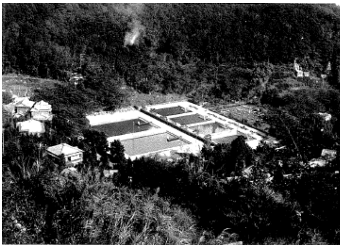
昭和12年（1937年）頃の熱海西山浄水場
