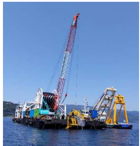
台船の大型ドラムに巻き付けた更新管を海底に布設している様子
