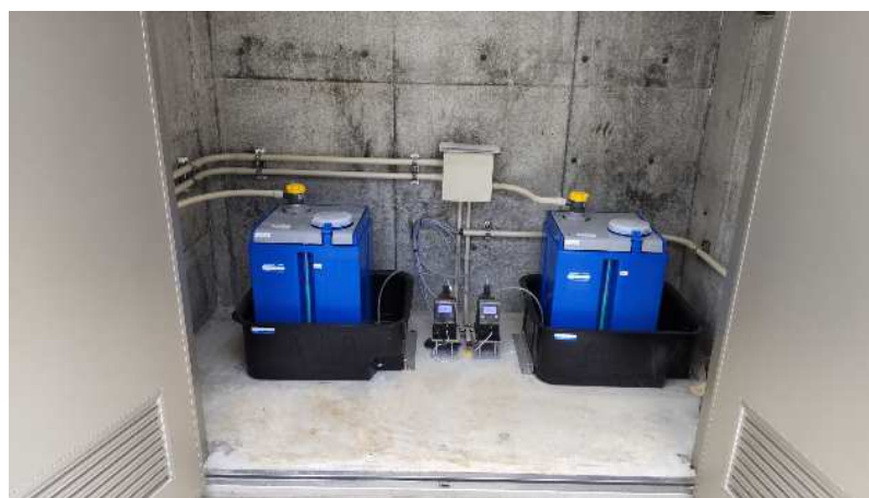
日金沢浄水場
