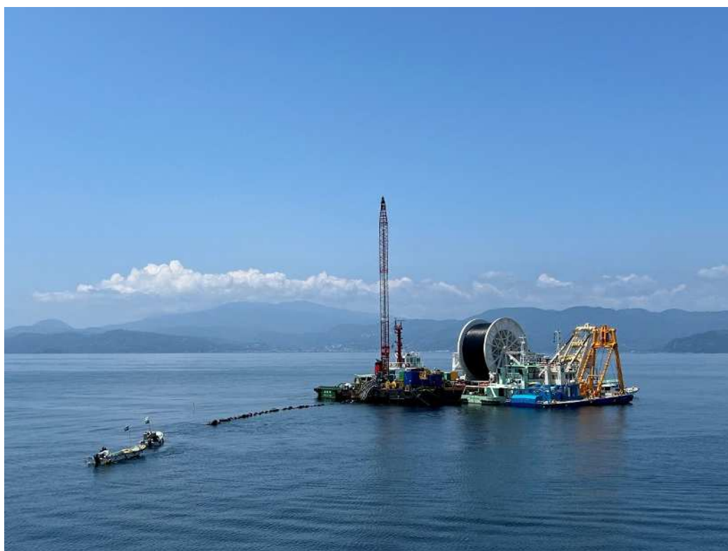
初島海底送配水管布設替工事（海底送配水管 WNG \phi 150 L=6,786.8m） 令和6年度完成
