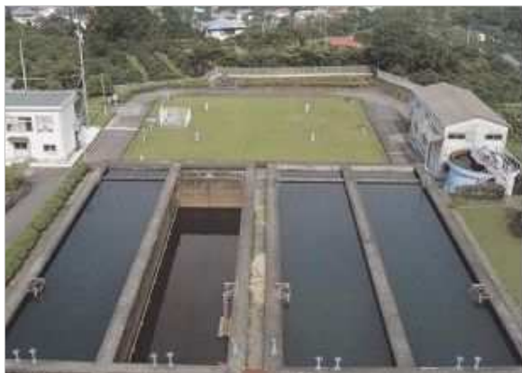
宮川浄水場 沈殿池
