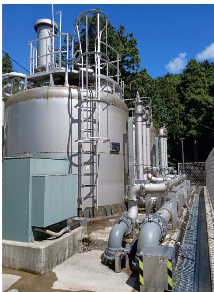
一里茶屋浄水場（急速ろ過方式 処理能力  $V=3,110 \text{ m}^3$ ） 令和4年度完成
