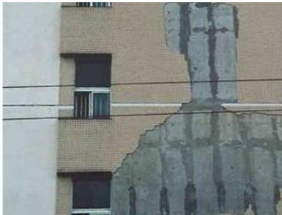
写真⑩ 外装材の破損、剥落
