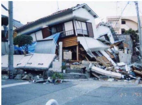
写真② 既に倒壊又は崩壊（一階の層崩壊）
