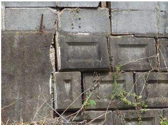
写真④ 水抜き穴の詰まり
