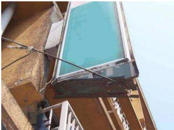
写真⑫ 突出部（手すり）の脱落
