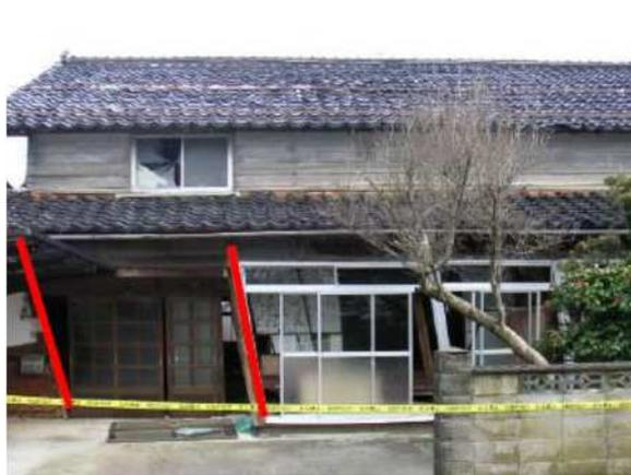
写真⑤ 構造部材の破損
