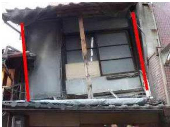
写真④ 建築物の傾斜
