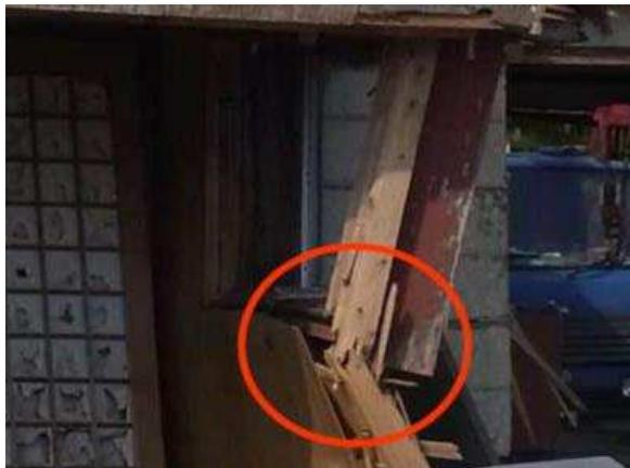
写真⑥ 構造部材同士のずれ
