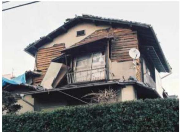
写真⑪ 突出部の腐食
