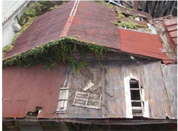
写真⑨ 外装材の剥落
