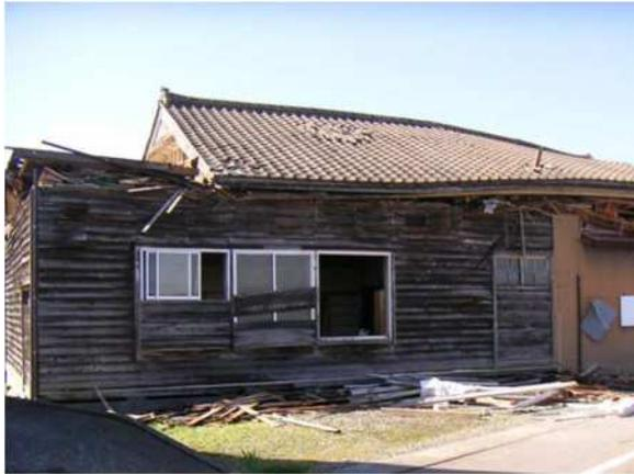
写真⑧ 屋根ふき材の破損
