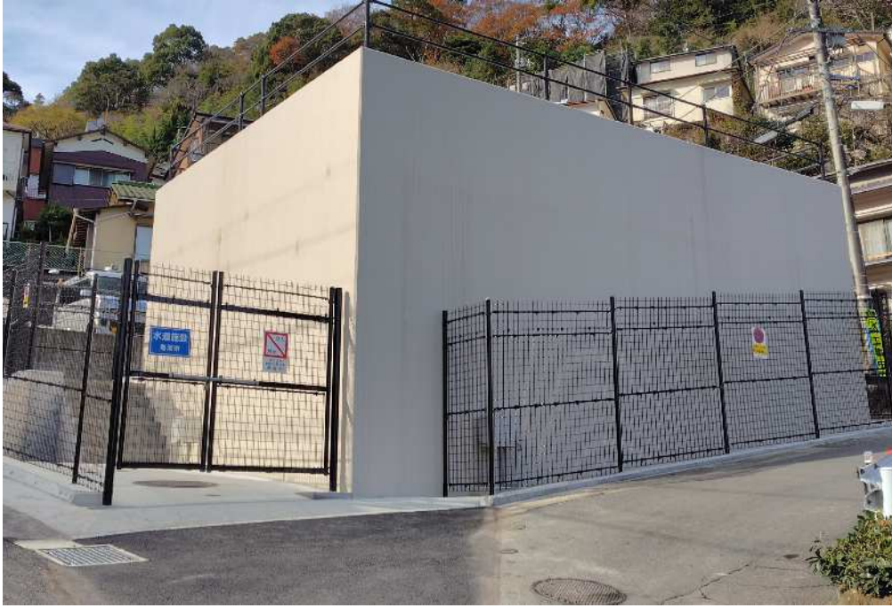
和田山第3配水池
