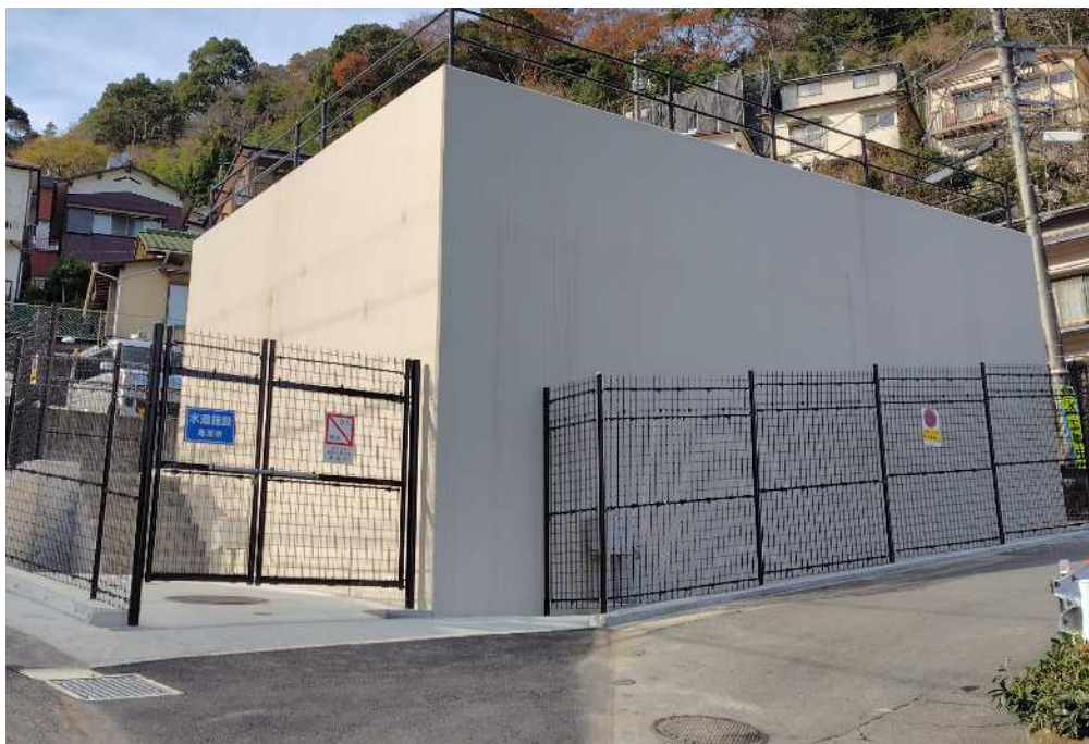
和田山第3配水池
