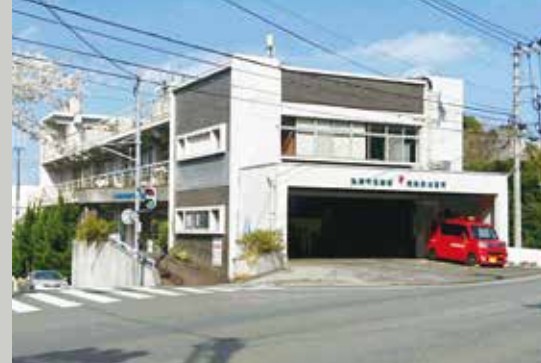
南熱海支所・消防署南熱海出張所の改築
