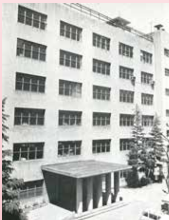
【昭和28年 現庁舎の完成】 出典：熱海市史 下巻
