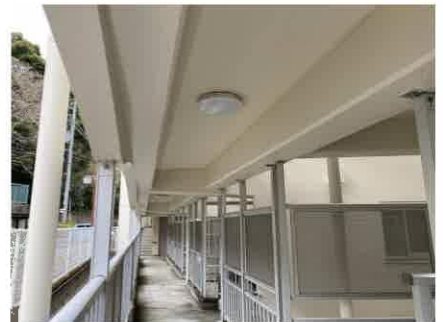
住棟内共用部の LED 照明設置 (寺坂団地)
