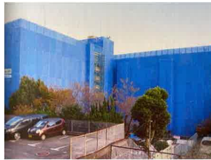
屋上の防水性維持のための改修(泉議業団地)
