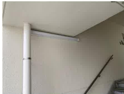
住棟内共用部の LED 照明設置 (笹良ヶ台団地 8・9・10 棟)
