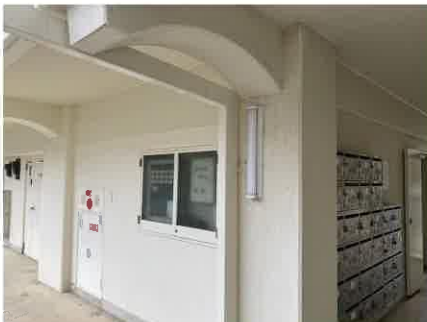
住棟内共用部の LED 照明設置 (笹良ヶ台団地 3・4 棟)
