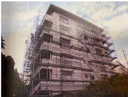
外壁の劣化に対応した改修(和田山団地)
