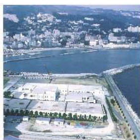
浄水管理センター全景
