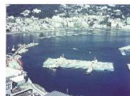
熱海湾に曳航された鋼殻体
