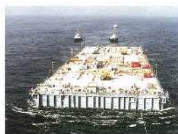
海上移送される鋼殻体
