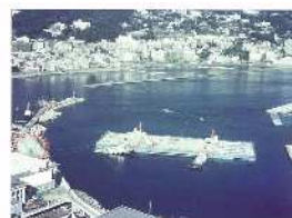
熱海市に曳航された鋼殻鉄筋
