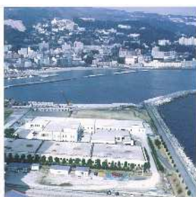
浄水管理センター全景
