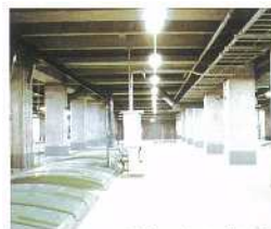
エアレーションタンク
