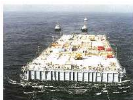
海上移送される鋼殻鉄筋
