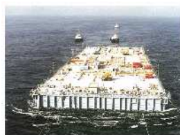
海上移送される鋼殻鉄筋
