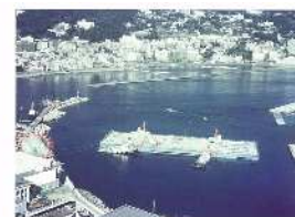
熱海湾に曳航された鋼殻鉄筋
