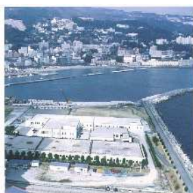
浄水管理センター全景
