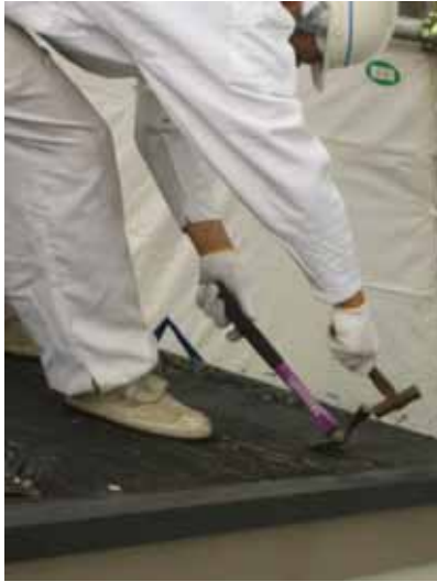
接合固定部分の取外し
