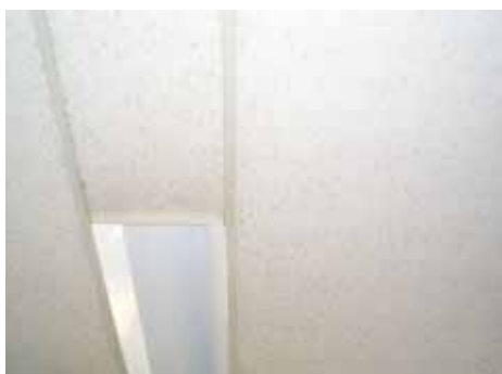
図表 3 - 93 石綿含有ロックウール吸音天井板
