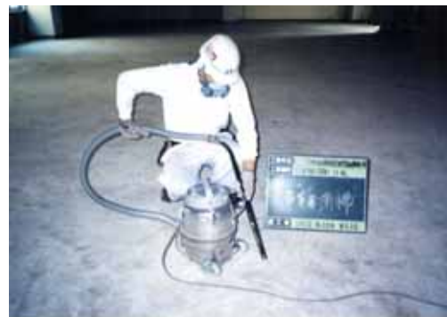
終清掃 高性能真空掃除機使用
