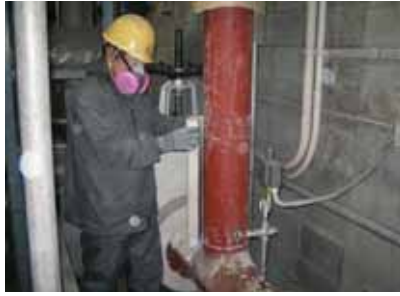
図表 3 - 88 保温材被覆撤去
