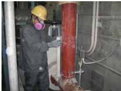
図表 3 - 90 保温材の取外し
