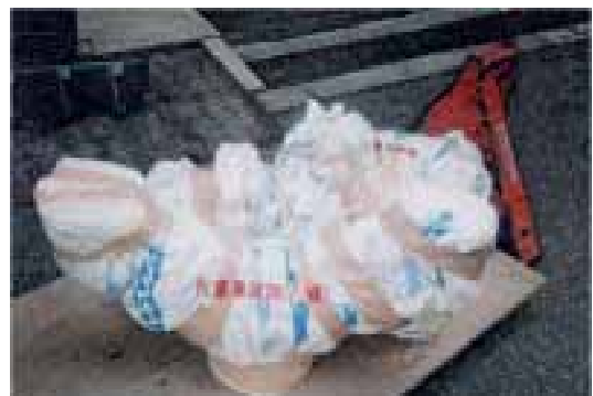
除去した保温材付配管を梱包、特別管理産業廃棄物として処理
