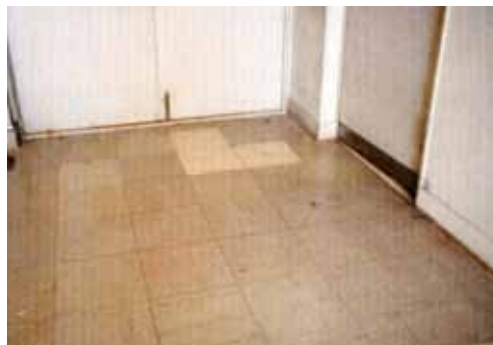
図表 3 - 94 石綿含有ビニール床タイル
