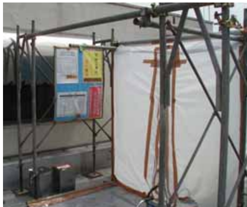
図表 3-60 セキュリティゾーン前に設置した石綿障害予防規則に基づく4種の表示及び掲示
