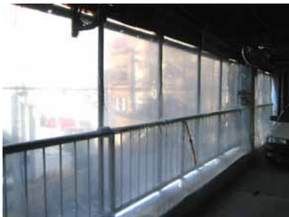
図表 3-52 外壁の飛散防止措置例(外部側にメッシュシート張り、内部側に隔離用プラスチックシート張り)
