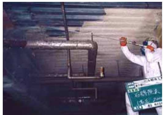
図表 3-73 ウォータージェット工法の例
