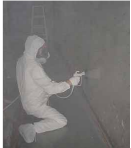
図表 3 - 76 粉じん飛散抑制剤の散布による湿潤化
