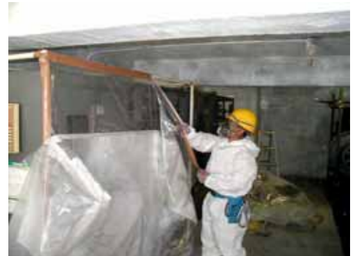
図表 3-85 養生シートの撤去
