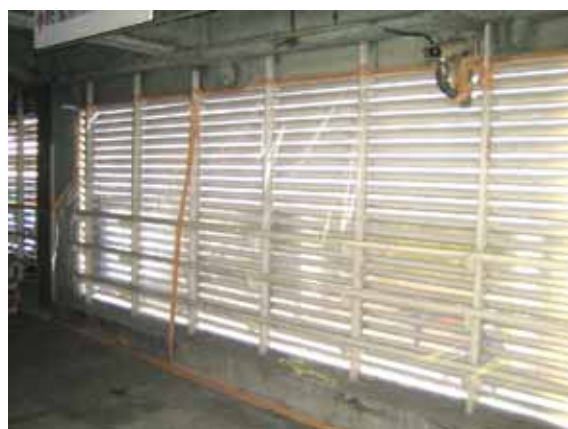
図表 3-54 外壁の隔離例(ガラスの手前をプラスチックシートで隔離)
