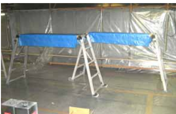
図表 3 - 71 可搬式作業台の例
