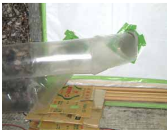
図表 3 - 69 排気ダクトと隔離の取合い(隙間を完全に封鎖)
