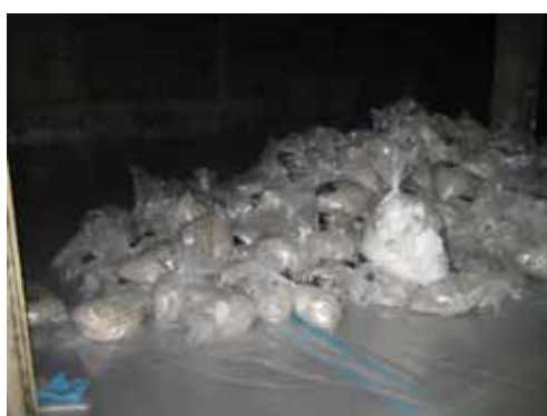
図表3-82 除去した石綿廃棄物の一時保管
