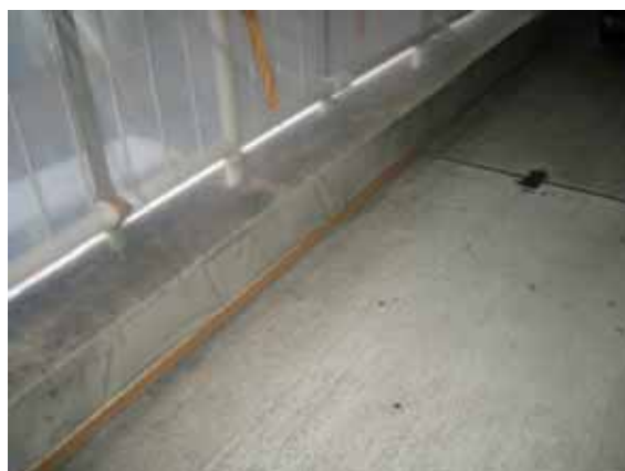
図表 5-53 外壁の飛散防止措置詳細(隔離用プラスチックシート足元固定方法)
