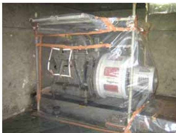
図表 3-55 作業場内部の養生例(エレベータ機械:接触防止用に布板敷き、発生熱を放散させる小窓を設置)
