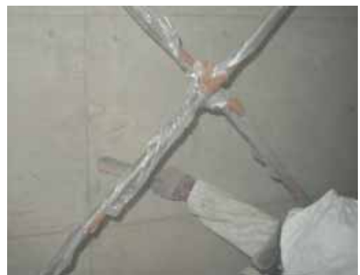
図表 3 - 78 ワイヤブラシを用いた擦り落とし作業(ブラッシング)
