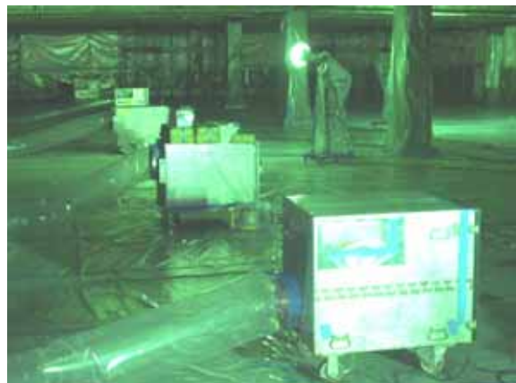
図表 3 - 68 集じん・排気装置への排気ダクトの取付け
