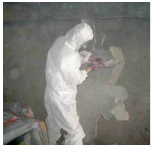
図表 3 - 77 手工具(ヘラ)を使用した石綿含有吹付け材の除去作業
