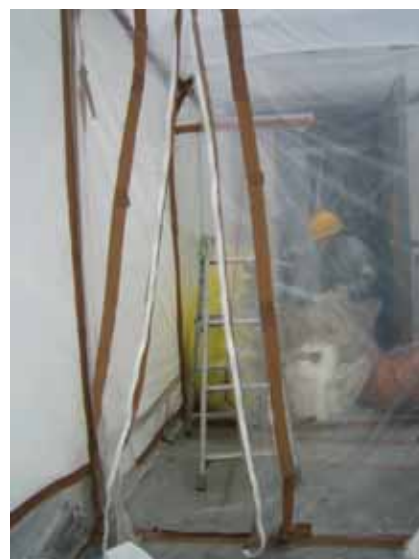
図表 3-62 セキュリティゾーン各室のジッパ式仕切りの例
