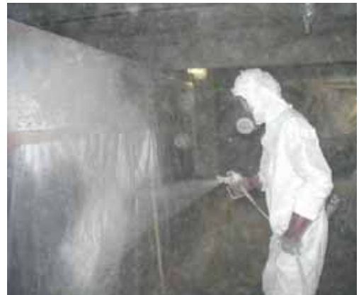
図表 3-84 養生シートへの粉じん飛散防止処理剤の散布
