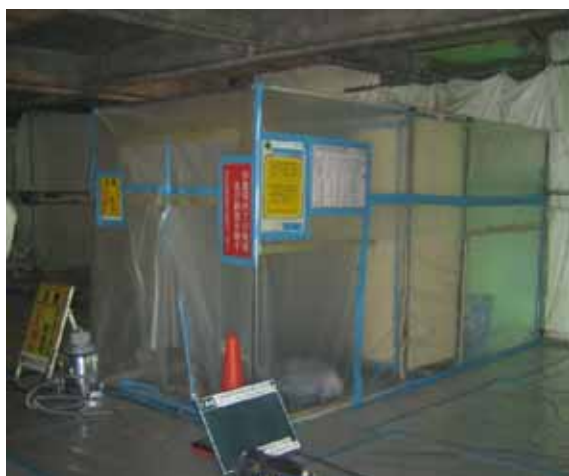
図表 3-56 セキュリティゾーン外観
