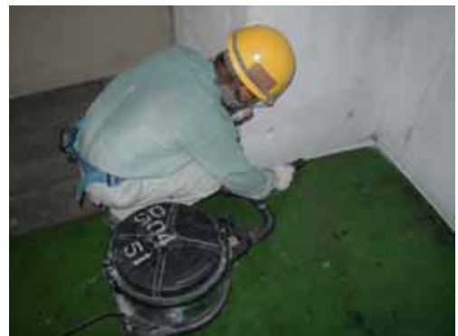
図表 3-86 高性能真空掃除機を用いた作業場内の仕上げ清掃
