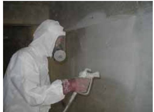
図表 3-83 除去した後の下地面への粉じん飛散防止処理剤の散布
