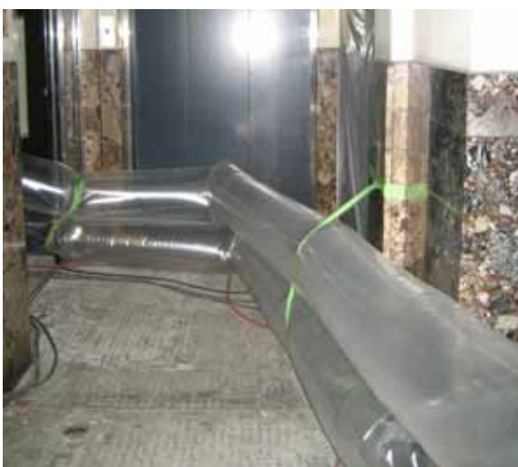
図表 3 - 70 排気ダクトの配管(原則として外気へ排気)
