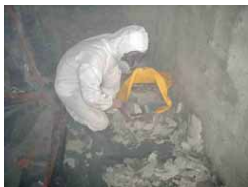
図表3-79 除去した石綿廃棄物の袋詰め（一重目）
