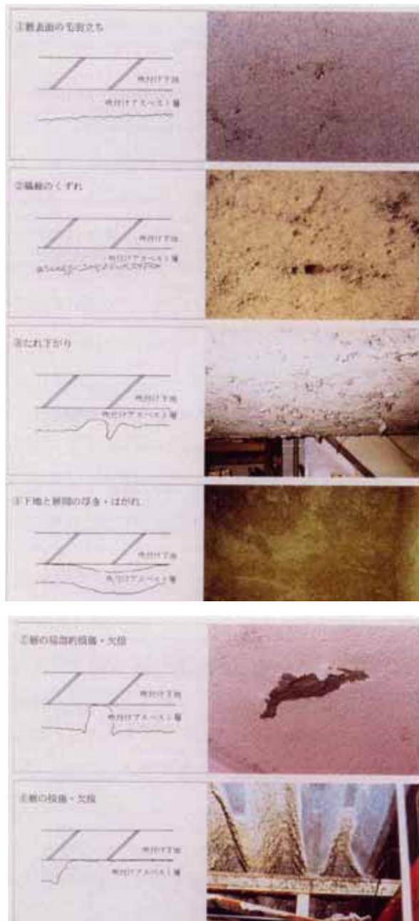
図表 3-16 吹付け石綿の劣化損傷状態のモデル図(その 1)
